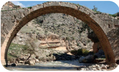
Ormanardı (Gerre) Köprüsü
